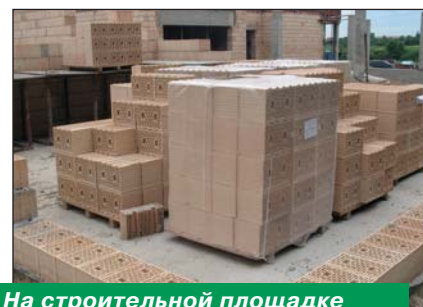
На строительной площадке
