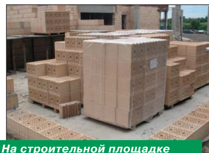
На строительной площадке
